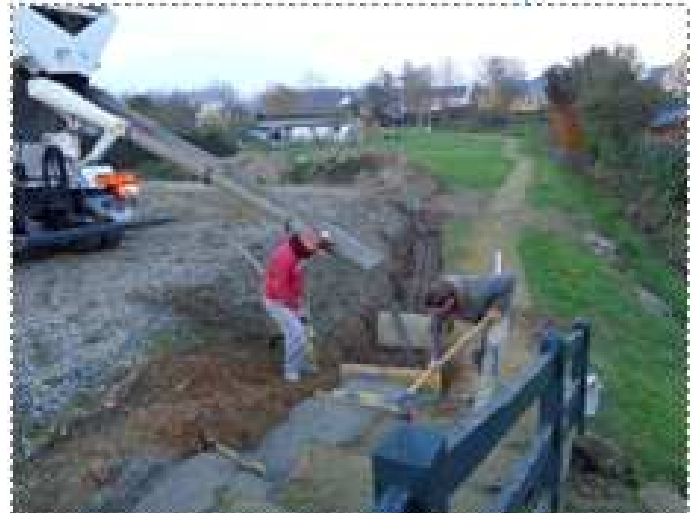
Mur de soutènement pour le nouveau parking, Rue Principale
