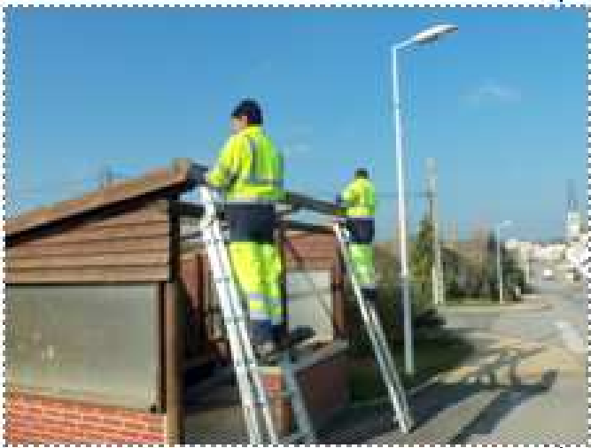
Réfection de l'abri bus
