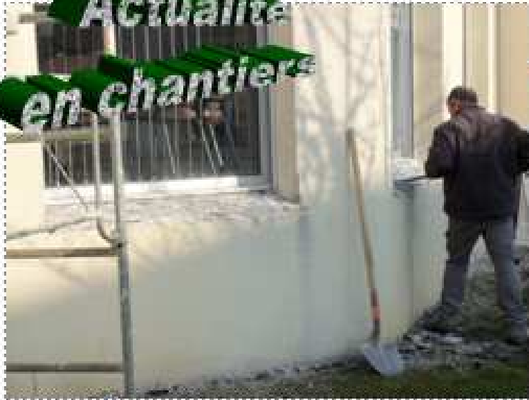
Nouveaux appuis de fenêtre pour la mairie
