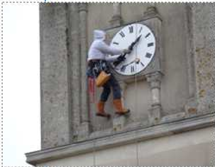
Remplacement des aiguilles de l'horloge de l'église
