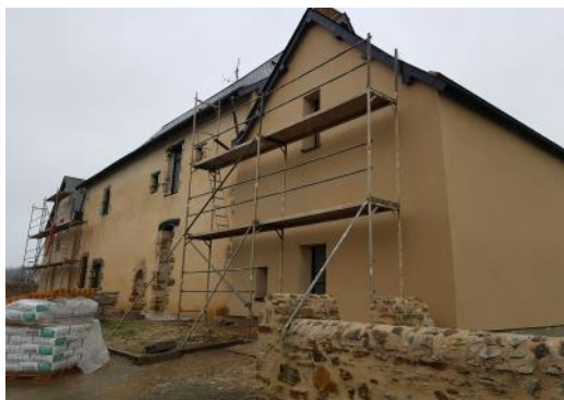
Travaux de rénovation énergétique des logements de la Métairie
