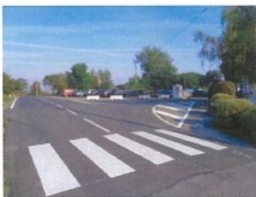
Nouvel accès à Qualipac Aluminium
