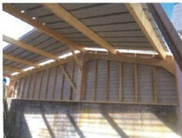
Extension du préau à l'atelier communal - Mise en place des nouveaux panneaux
