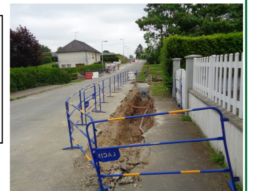
Travaux de réfection de la passerelle, rue principale Travaux route de la Crue 1ère phase : réfection des réseaux eaux pluviales et assainissement
