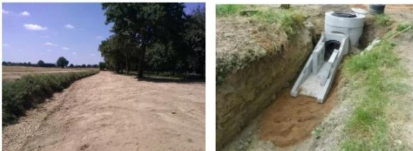
Figure 2 Aménagement du lit du cours d'eau et conduite eau pluviale
