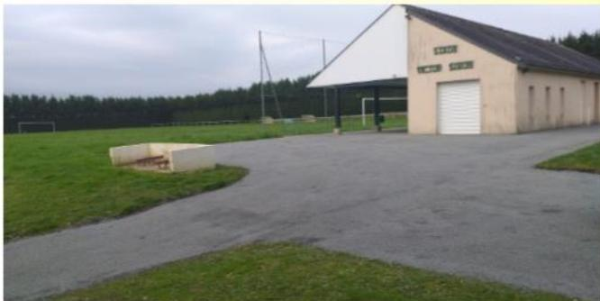
Réalisation d'un bicouche sur le chemin d'accès au vestiaires et d'un monocouche autour du bâtiment
