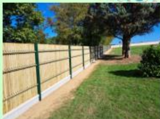
Mise en place d'une nouvelle clôture au cimetière
